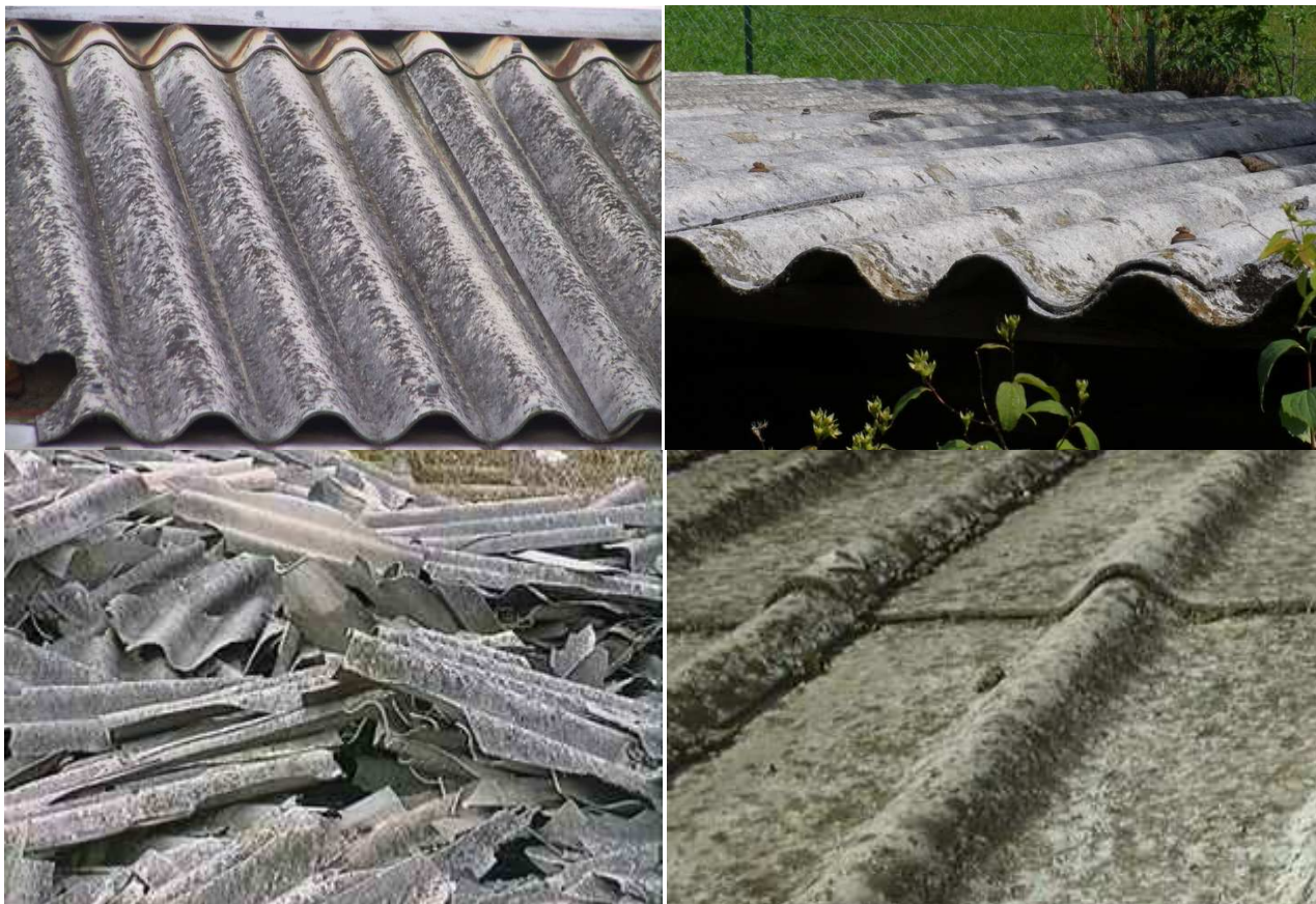
Figura 1: Esempi di utilizzo di eternit in lastre ondulate nell'edilizia civile.
