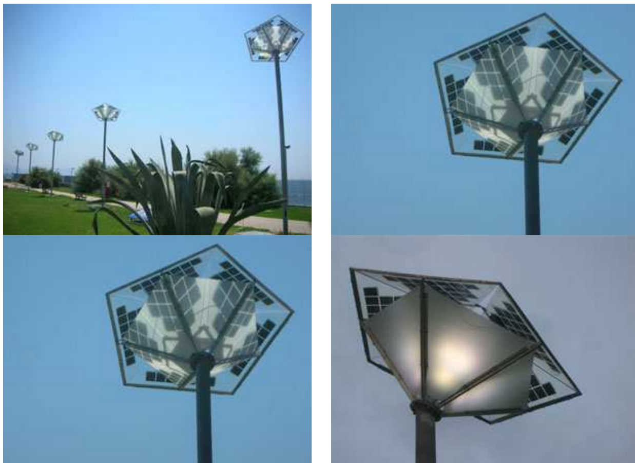
Figura 18: lampioni fotovoltaici
